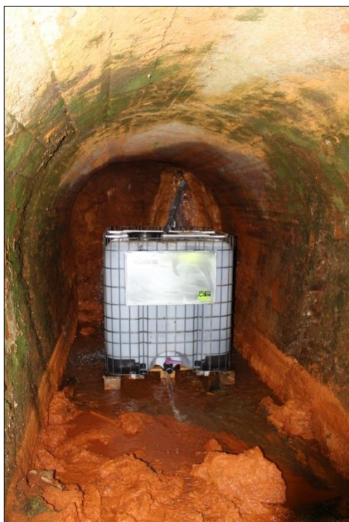
Obr. 38: Pasívny systém čistenia banských vôd umiestnený v portáli štôlne Agnes
