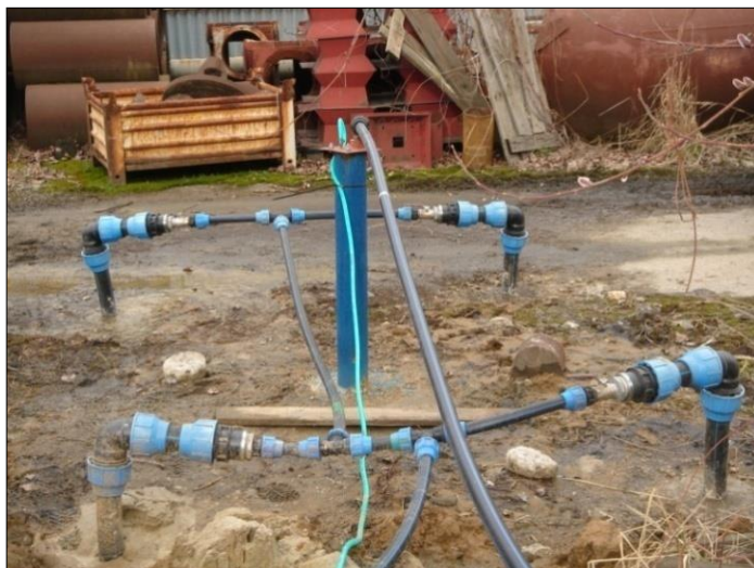
Obr. 11: Air spargingový vrt a štvorica odsávacích ventingových vrtov (foto GEOSlovakia, s.r.o, Košice)
