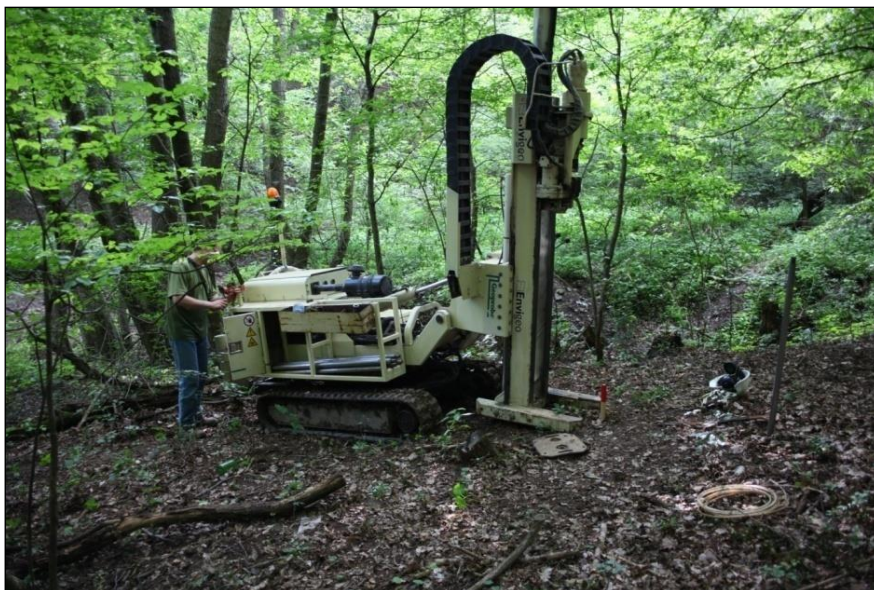
Obr. 61: Súprava Geoprobe 66DT pri odbere vzoriek v Pukanci (foto: R. Hovorič, 2014)
