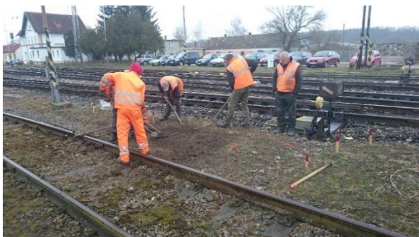
Obr. č. 4 Pracná realizácia ručných predkopov v priestore aktívneho koľajiska
