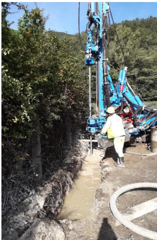
Obr. č. 19 a 20 Tryskanie podzemnej tesniacej steny
