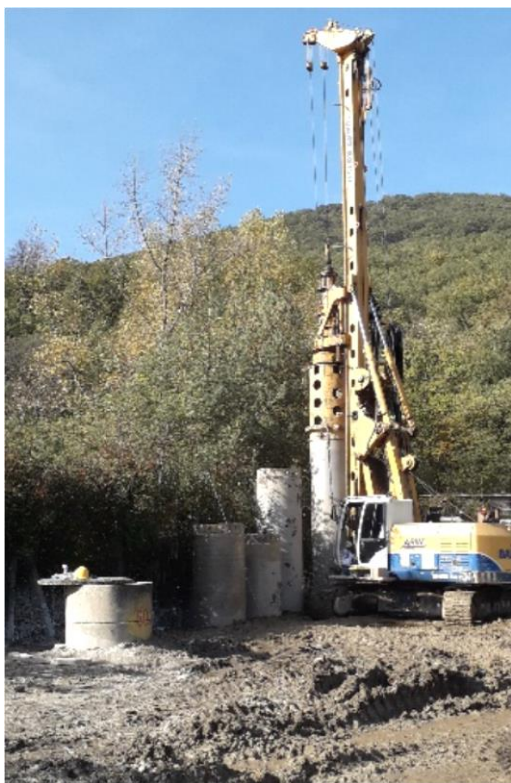
Obr. č. 21 a 22 Vrtanie reakčných studní a brány pred zabudovaním
