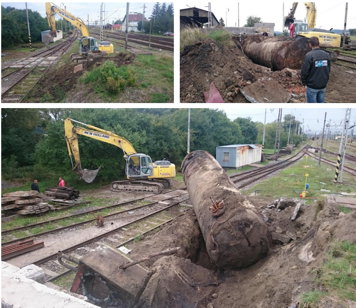
Obr. č. 12, 13, 14 Likvidácia nádrží úložiska PHM
