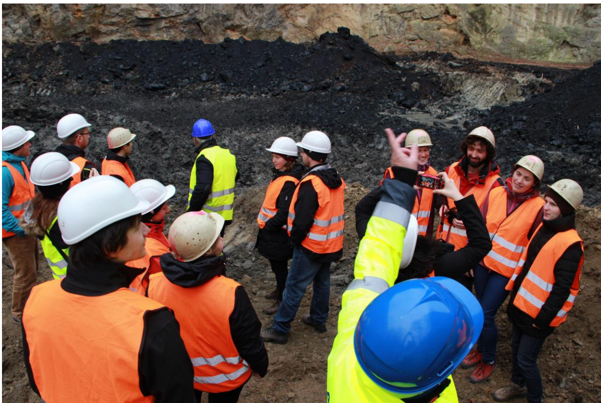
Obr. č. 8 a 9 Priebeh sanácie EZ v kameňolome Srdce sledovali počas exkurzie aj účastníci tréningového kurzu vysokoškolských pedagógov a doktorandov (Modra, 21. – 23. január 2015) financovaného zo zdrojov OP ŽP v rámci osvetového projektu INTEGRÁCIA (ITMS kód projektu: 24140110300, prijímateľ NFP: SAŽP, termín realizácie: 9/2014 – 8/2015, zdroj: archív SAŽP)
