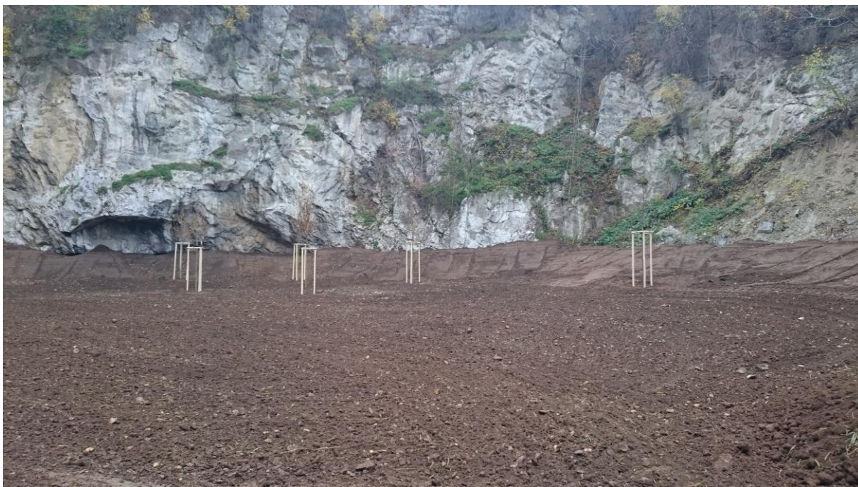
Obr. č. 10 Spätňý zásyp a rekultivačné práce v kameňolome
