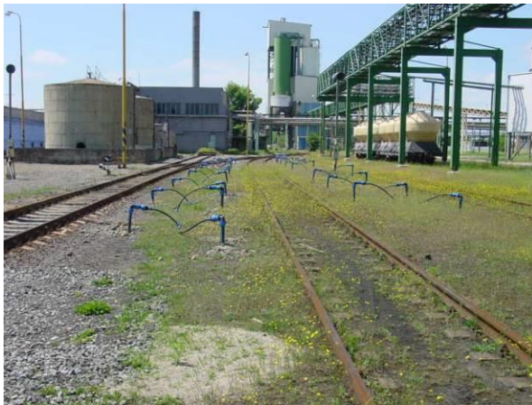
Obr. č. 3 Infiltračné drény počas prvej etapy v okolí nádrží
