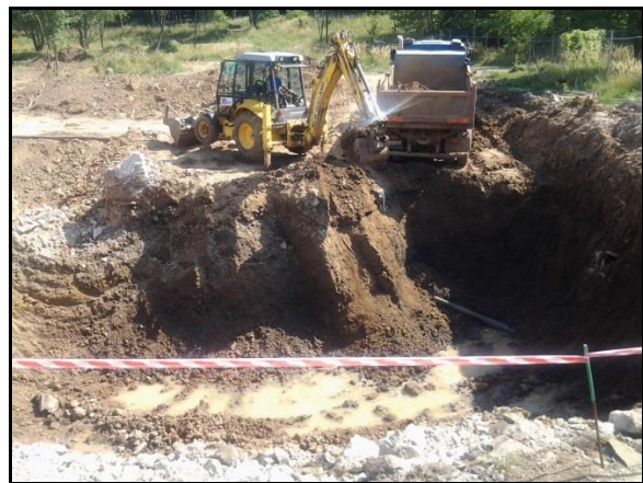
Obr. č. 5 a 6 Sanácia zemín ex situ – výkopové práce v čiastkovej lokalite Pekáreň
