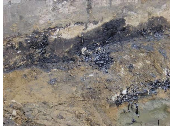
Obr. č. 2 Nátoky mazutu v okolí nádrží
