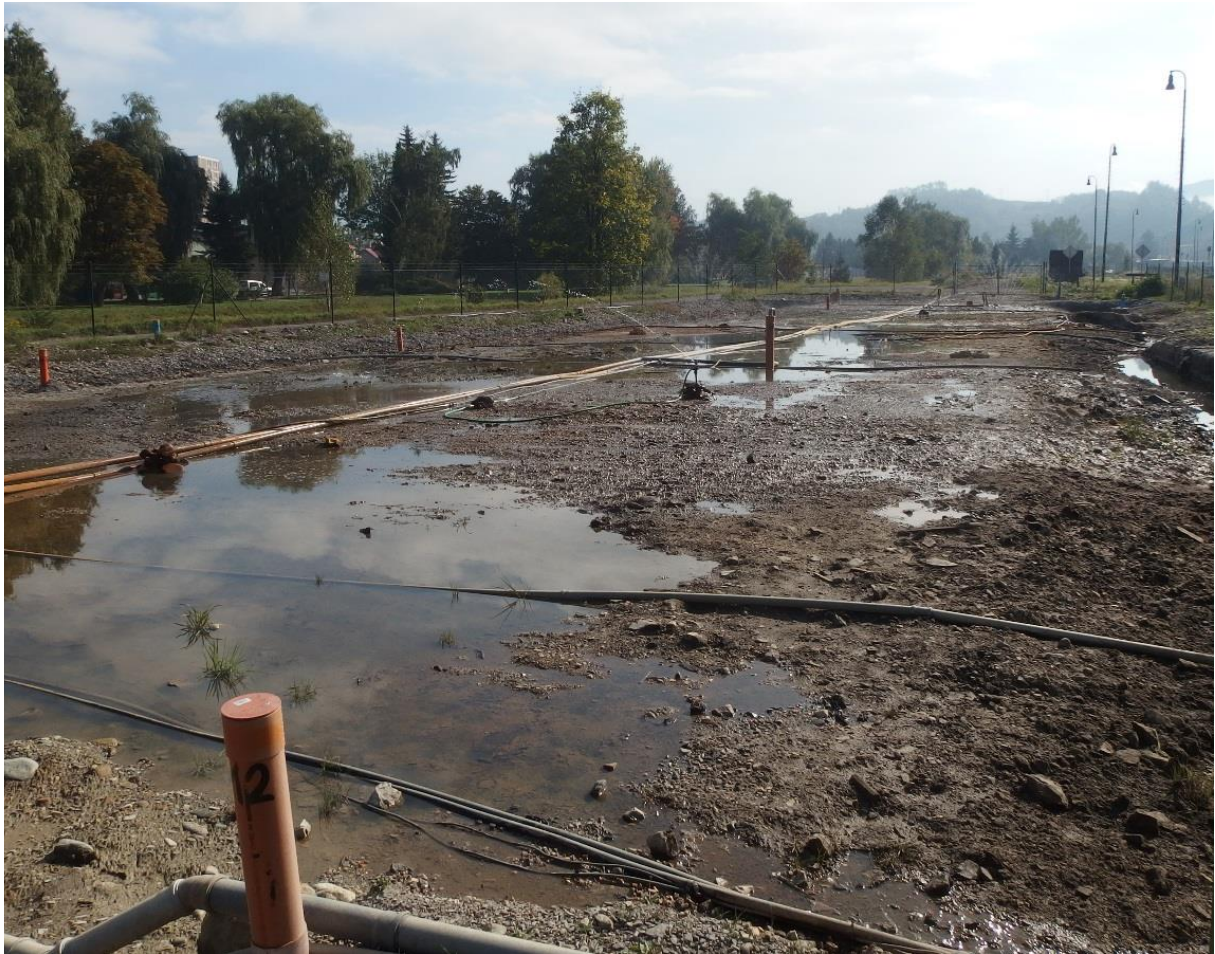
Obr. č. 6 Sanácia znečistených zemín in situ (Zdroj: MŽP SR)
