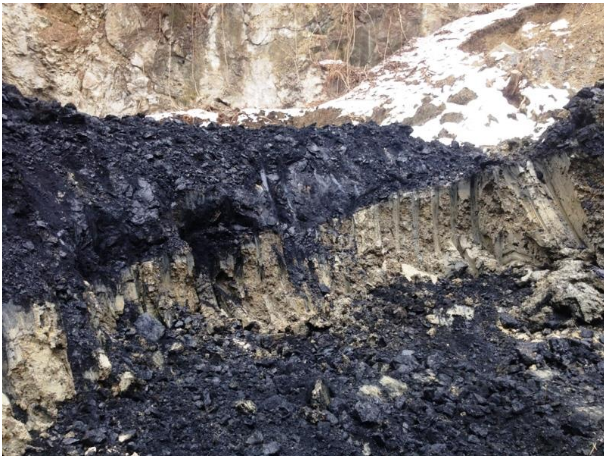
Obr. č. 3 Vrstva tesniaceho ílu vmiešaná medzi dve gudrónové vrstvy
