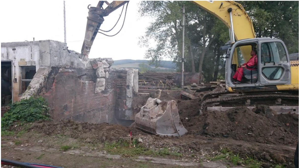
Obr. č. 15 Demolácia čerpadlovne
