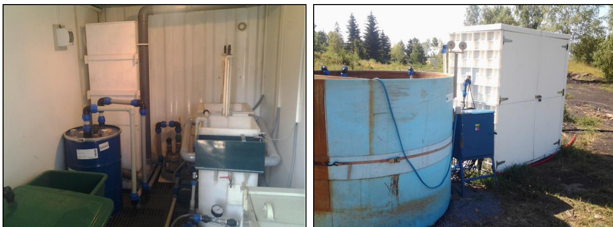
Obr. č. 15 a 16 Sanačná technológia v lokalite Pekáreň a Kotolňa SA [15]
