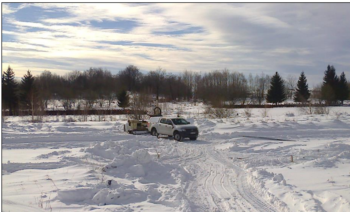
Obr. č. 21 Realizácia prieskumných sond vzorkovacou súpravou (®Geoprobe) v predsanačnej etape (foto J. Schwarz, január 2015)
