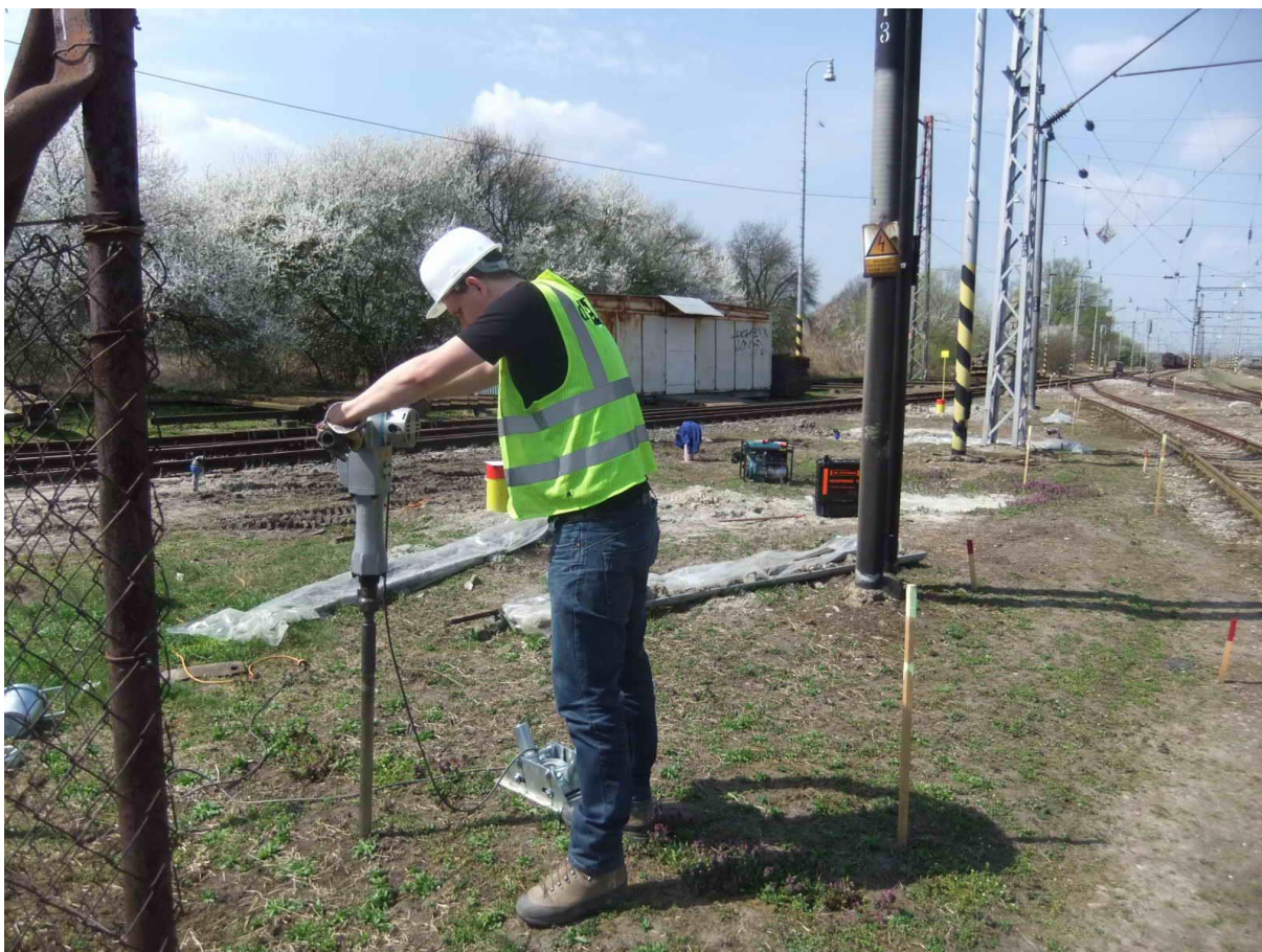
Obr. č. 6 a 7 Opatrné hĺbenie ventingových vrtov (Zdroj: MŽP SR)
