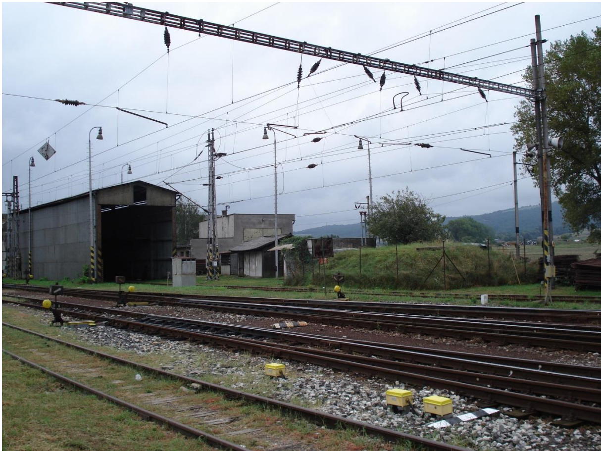
Obr. č. 3 Pohľad na objekt RD v obci Jablonica (2008, zdroj: ISEZ)
