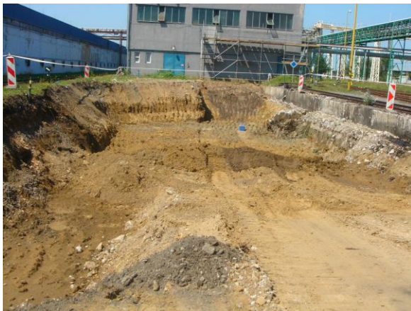
Obr. č. 5 Práce na sanácii ex situ počas druhej etapy
