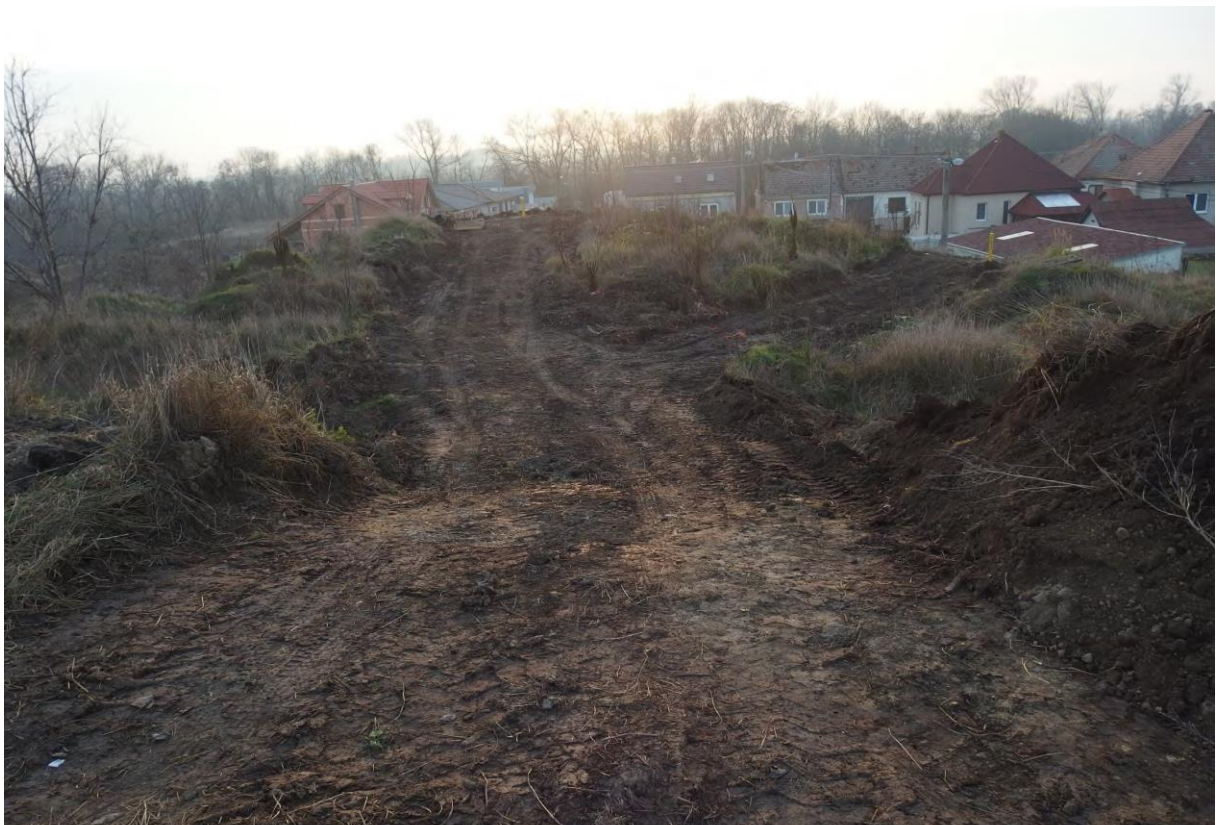
Obr. č. 4 a 5 Územie skládky pred začatím sanačných prác, 2014 (Zdroj: MŽP SR)
