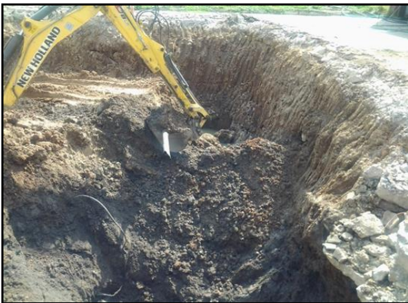
Obr. č. 5 a 6 Sanácia zemín ex situ – výkopové práce v čiastkovej lokalite Pekáreň
