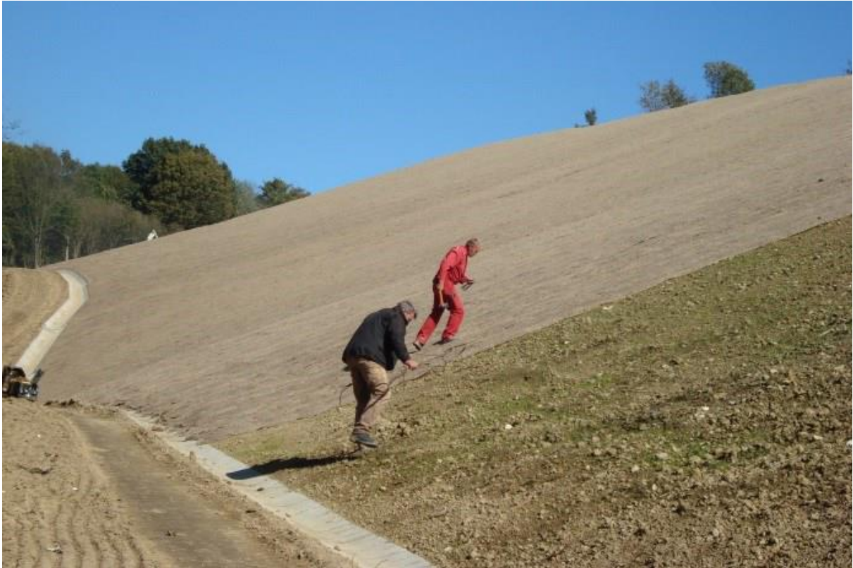
Obr. č. 10 Ukladanie biodegradovateľnej rohože
