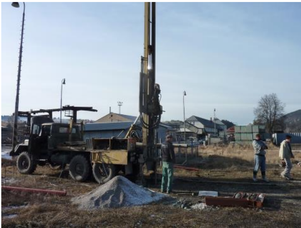
Obr. č. 3 Vrtanie monitorovacích a sanačných vrtov (Zdroj: MŽP SR)
