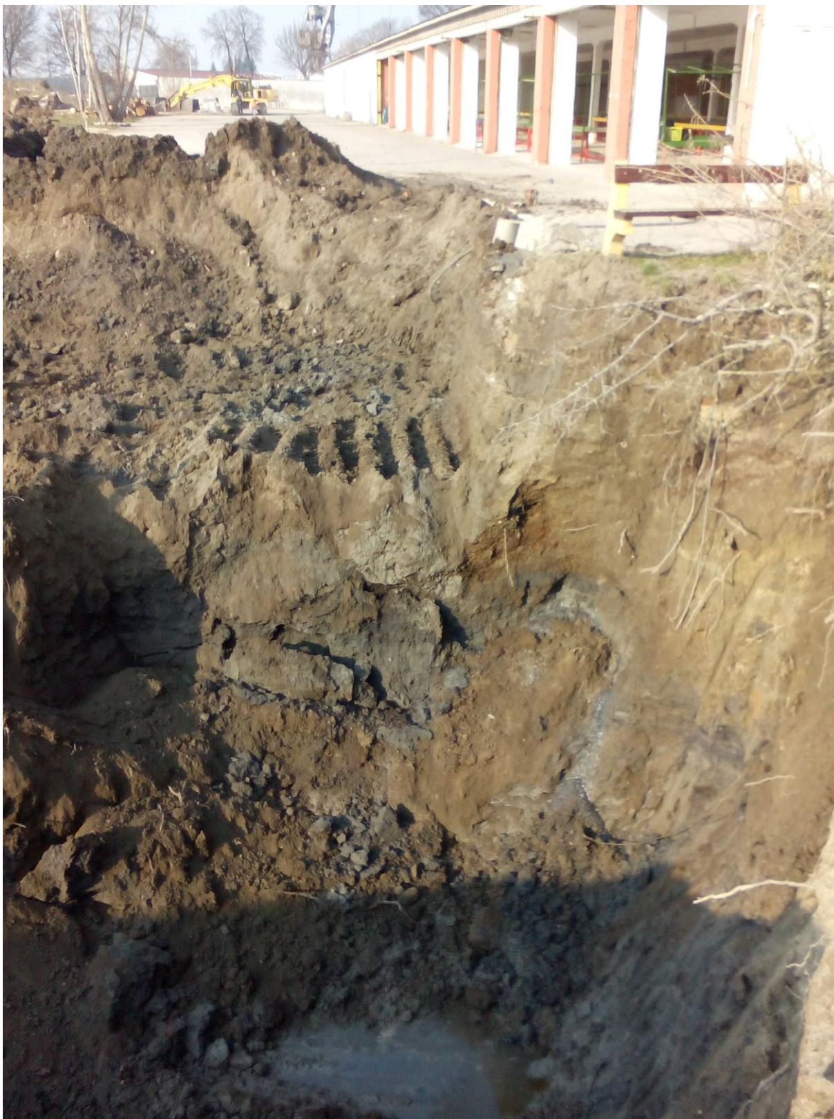
Obr. č. 16 Sanácia zemín ex situ v oblasti Autopark I
