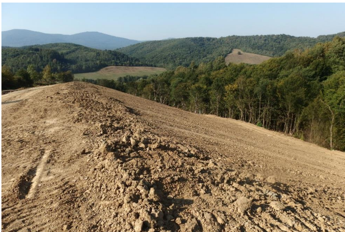
Obr. č. 6 Úprava tvaru skládky (Zdroj: MŽP SR)
