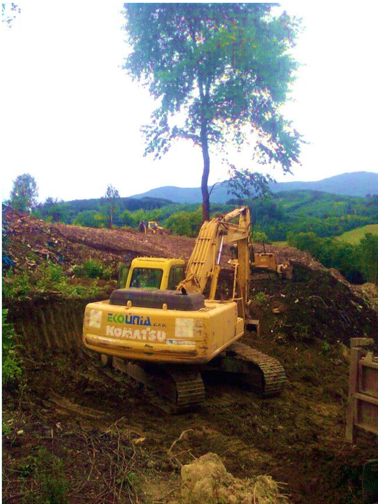
Obr. č. 8 Odťažba kontaminovaných zemín
