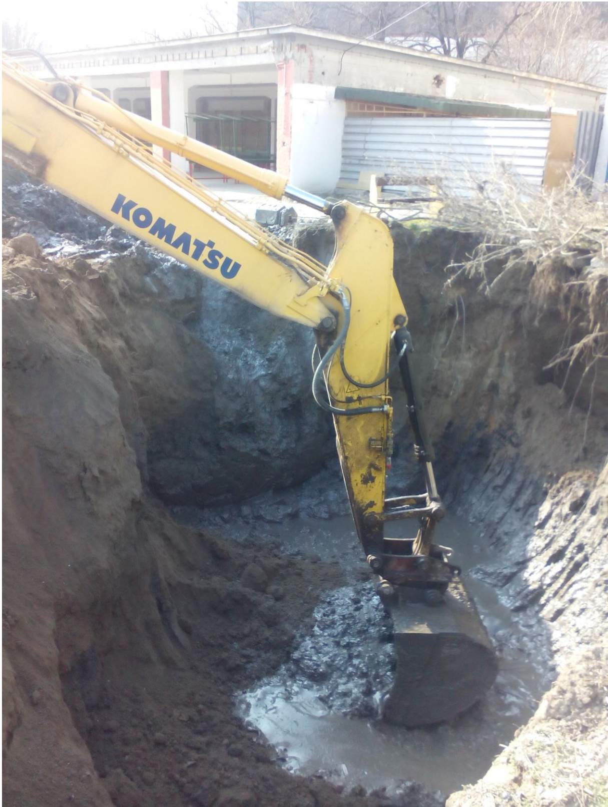
Obr. č. 13 Sanácia zemín ex situ v oblasti Autopark I
