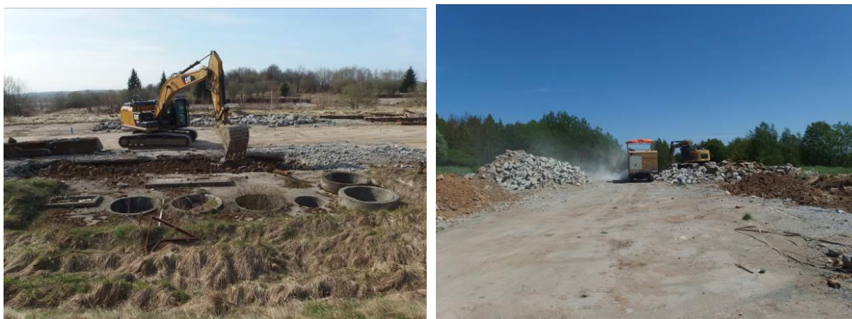
Obr. 28 a 29 Recirkulačná jednotka pred výkopom, Mobilný drvič. [15]
