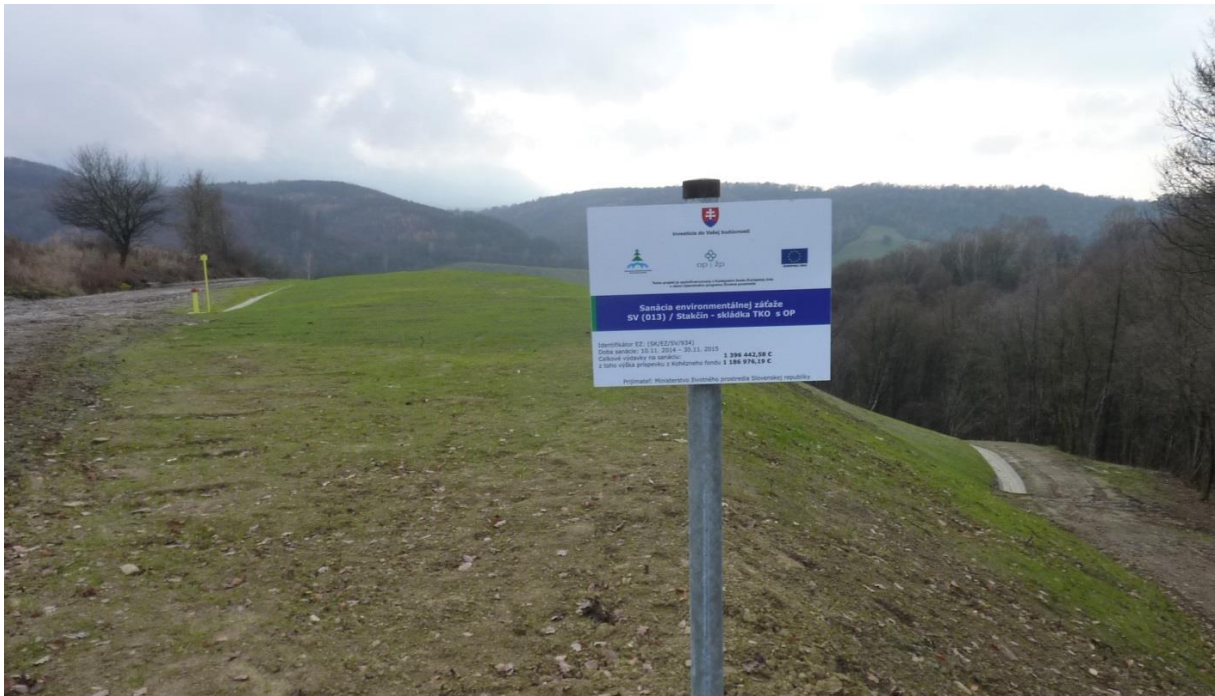
Obr. č. 12 a13 Sanovaná lokalita Stakčín – skládka tuhého komunálneho odpadu
