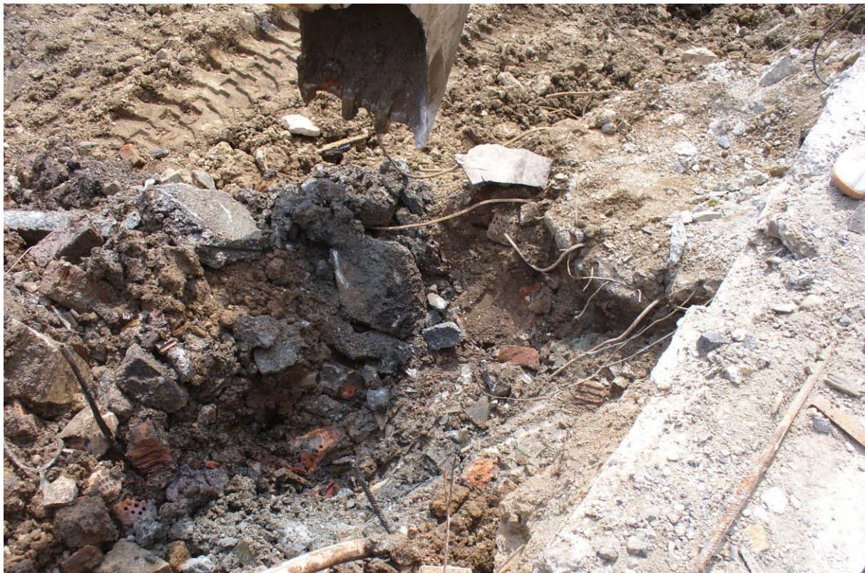
Obr. č. 4 a 5 Odkop a triedenie znečistených zemín
