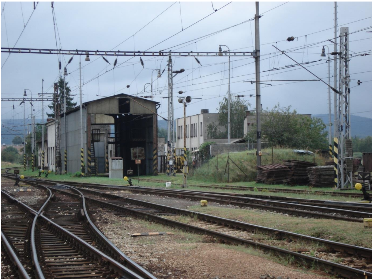
Obr. č. 2 Pohľad na objekt RD v obci Jablonica (2008, zdroj: ISEZ)
