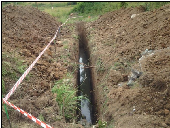
Obr. č. 19 a 20 Sanačné drény na čerpanie podzemnej vody a voľnej fázy ropných látok v lokalitách Pekáreň a Ihrisko [15].
