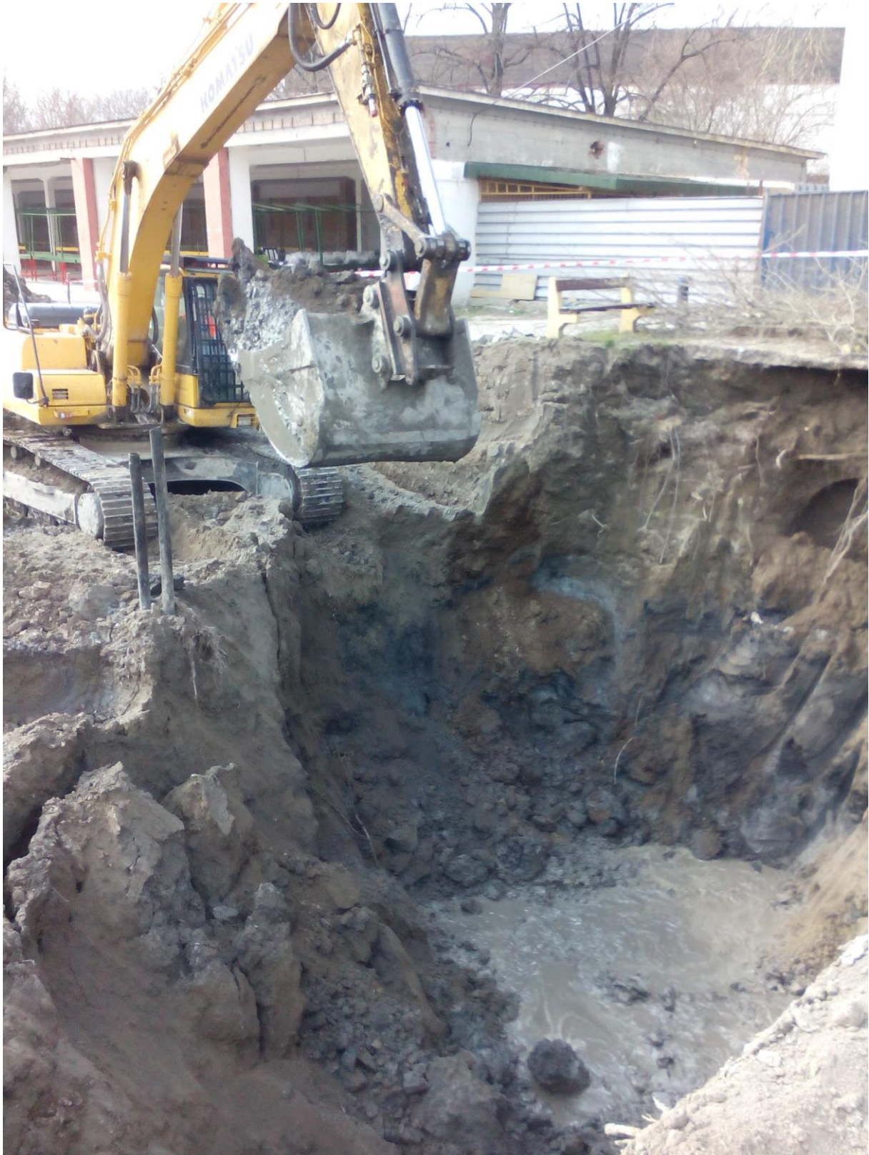
Obr. č. 15 Sanácia zemín ex situ v oblasti Autopark I
