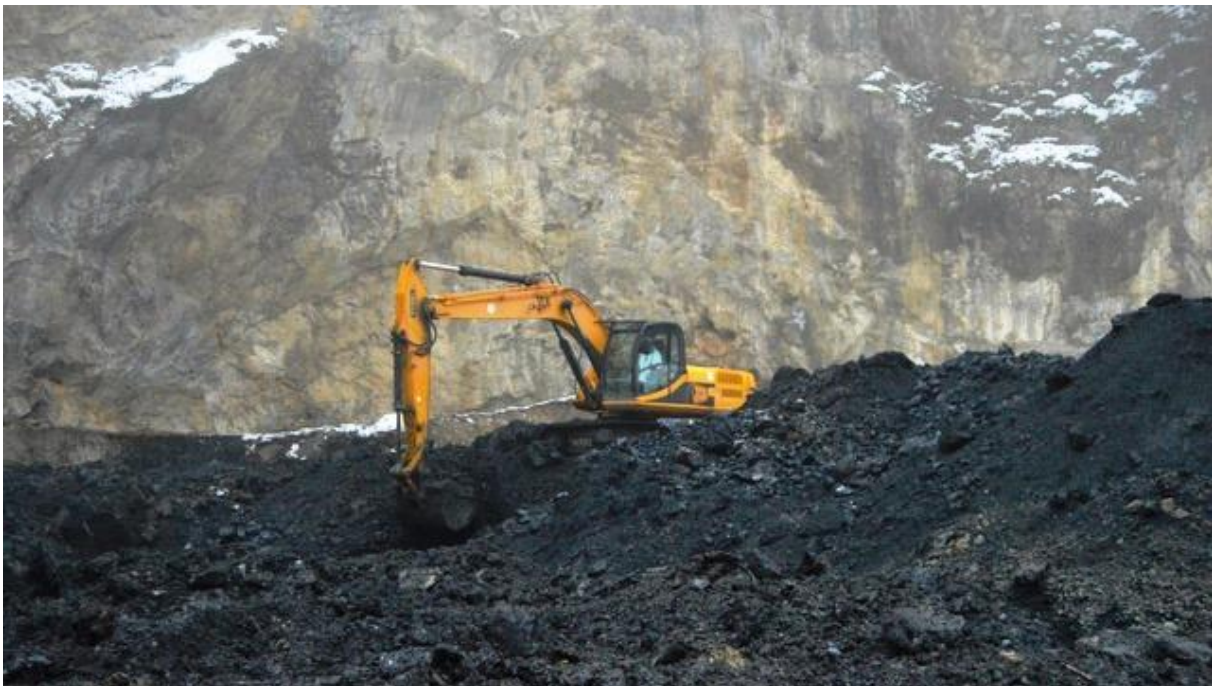
Obr. č. 4 Selektívna odťažba odpadu
