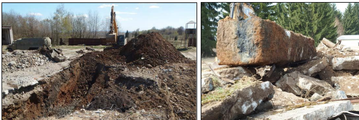
Obr. 26 a 27 Výkop na mieste umývacieho mostíka. Znečistené polohy zeminy ropnými látkami majú tmavšie sfarbenie, Znečistený betónový blok pred rozbitím. [15]
