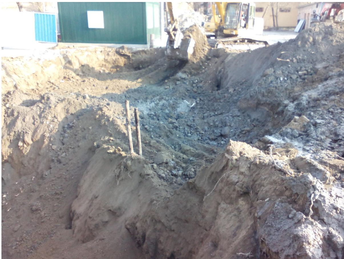
Obr. č. 17 Sanácia zemín ex situ v oblasti Autopark I
