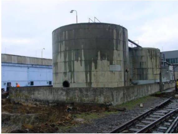
Obr. č. 1 Mazutové nádrže počas prvej etapy sanácie
