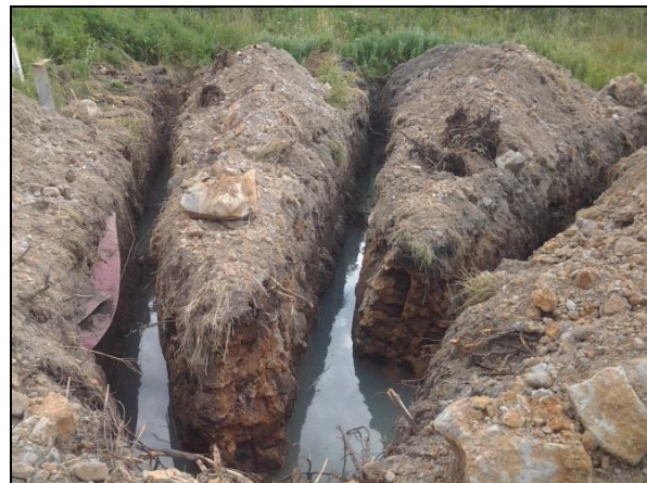
Obr. č. 19 a 20 Sanačné drény na čerpanie podzemnej vody a voľnej fázy ropných látok v lokalitách Pekáreň a Ihrisko [15].
