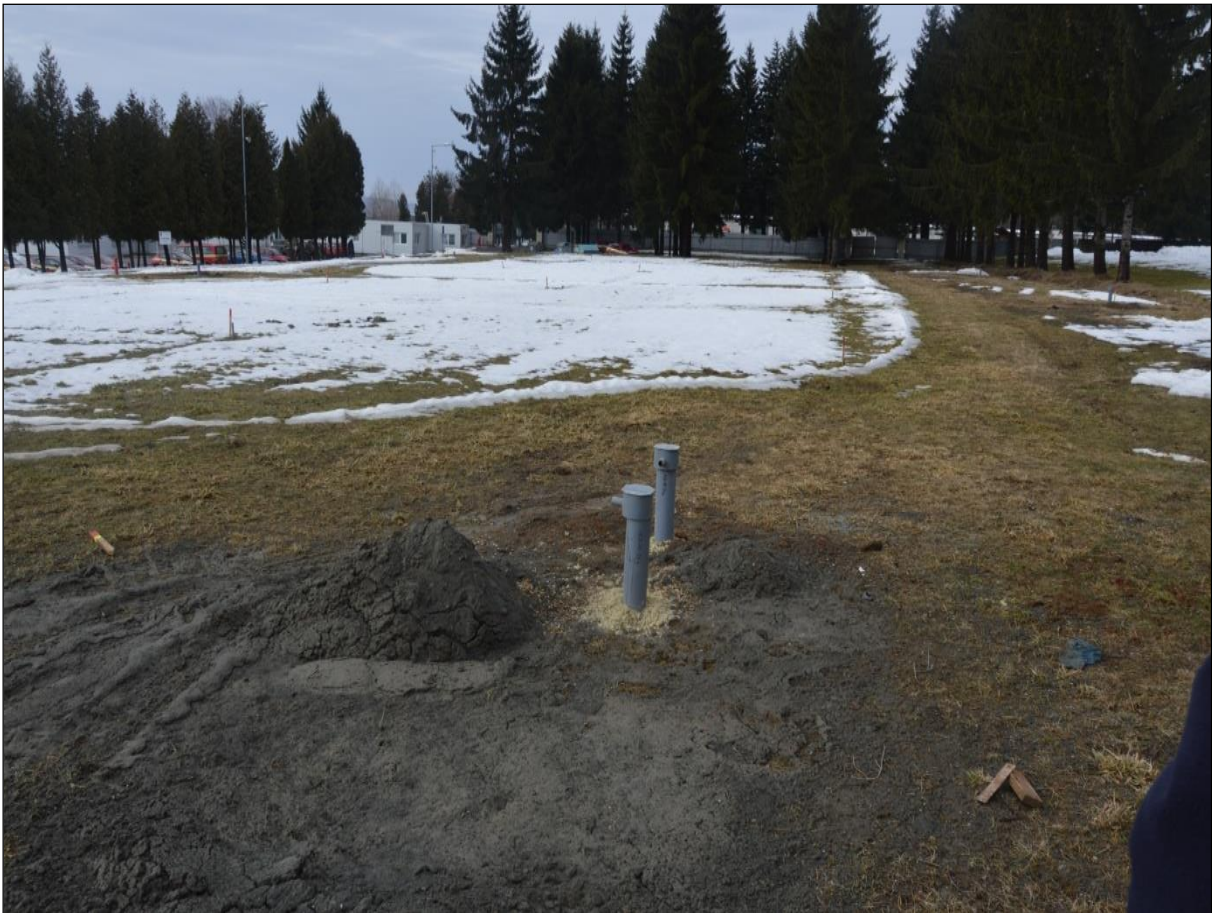
Obr. č. 23 Z priebehu sanačných prác v lokalite Garážové dvory [14]
