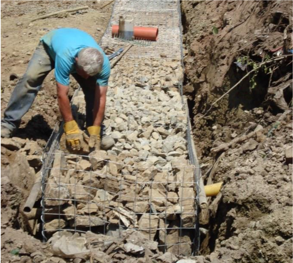
Obr. č. 9 Stabilizácia svahu gabiónovým múrom
