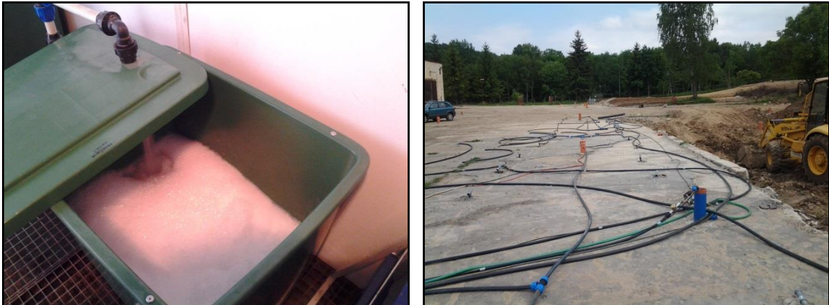
Obr. č. 10 a 11 Príprava NPAL v sanačnej technológii a rozvody do aplikačných vrtov
