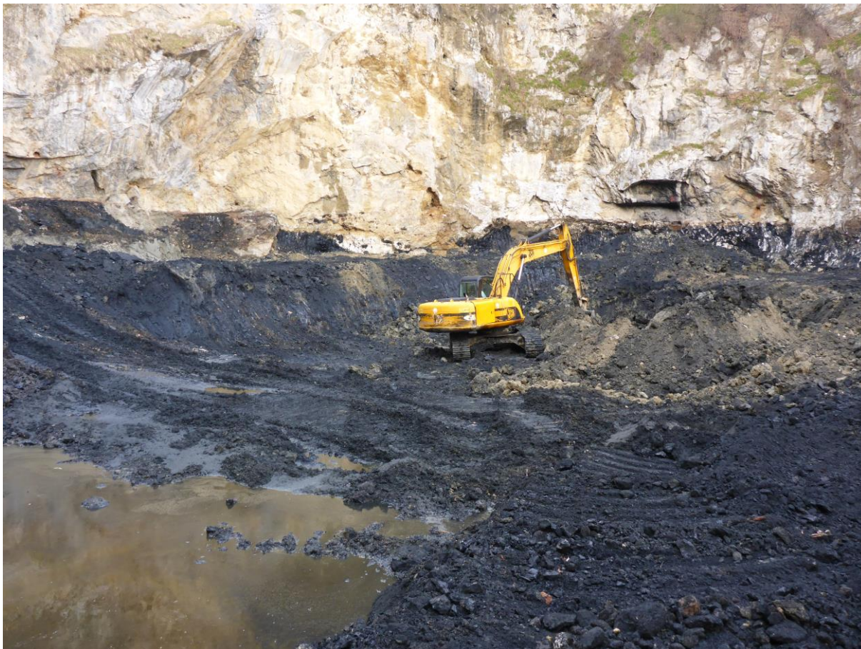
Obr. č. 5 Selektívna odťažba odpadu
