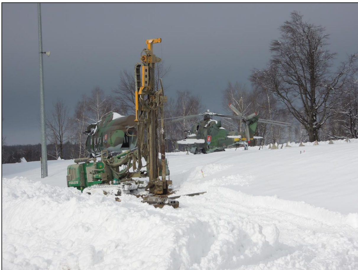
Obr. č. 22 Realizácia prieskumných sond vrtnou súpravou Fraste v predsanačnej etape (foto J. Schwarz, január 2015)
