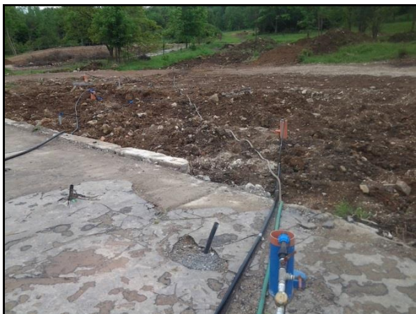
Obr. č. 13 a 14 Čerpanie podzemnej vody – lokality Pekáreň a Ihrisko
