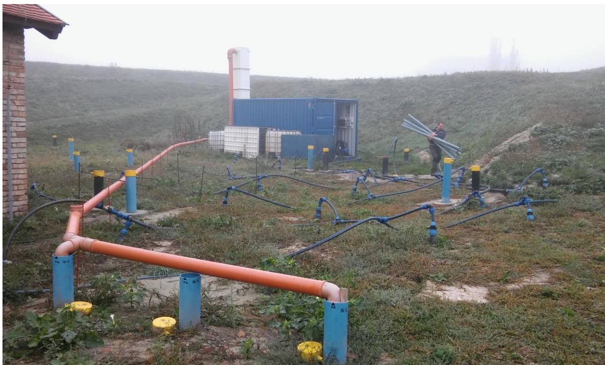
Obr. č. 18 – 21 Sanácia zemín pásma nasýtenia a podzemnej vody metódami in situ
