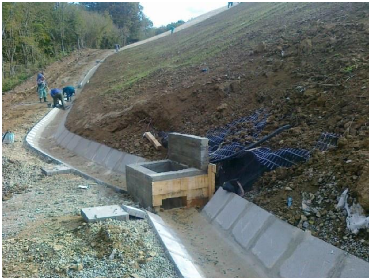
Obr. č. 7 Kontrolná šachta 2 – dolný rigol
