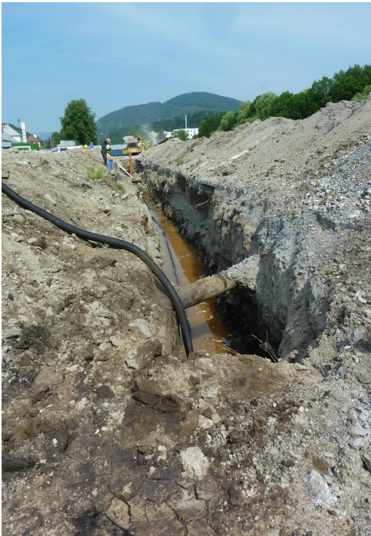
Obr. č. 10 Realizácia sanačného drénu (Zdroj: MŽP SR)
