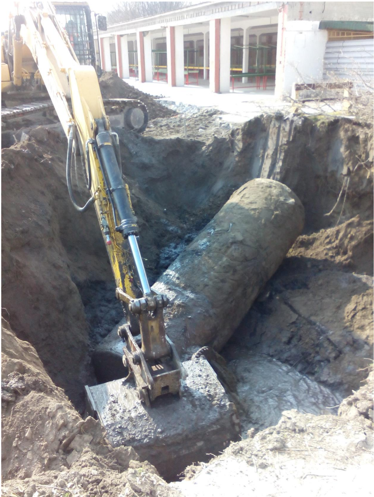
Obr. č. 12 Sanácia zemín ex situ v oblasti Autopark I
