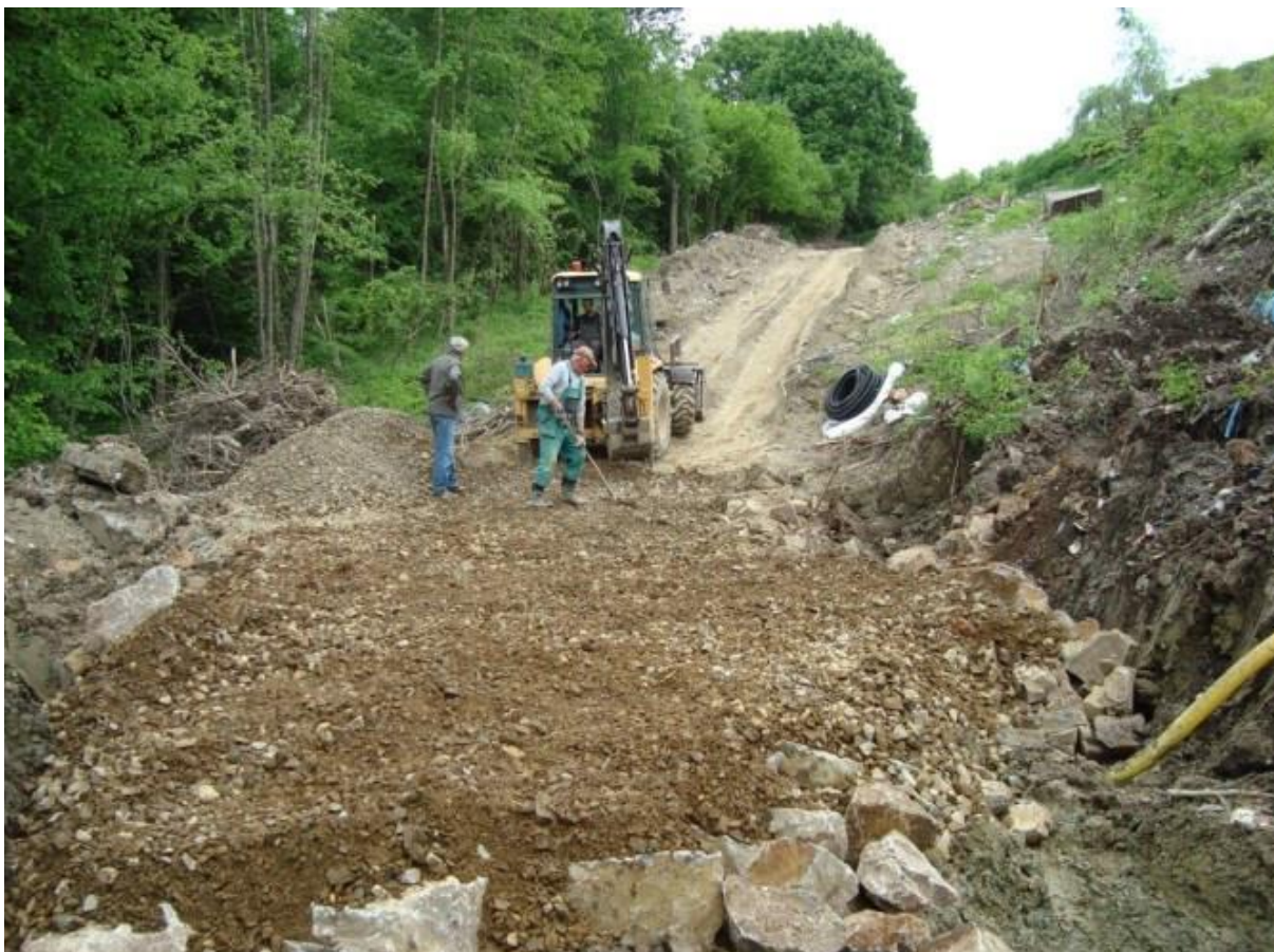
Obr. č. 5 Budovanie účelovej cesty
