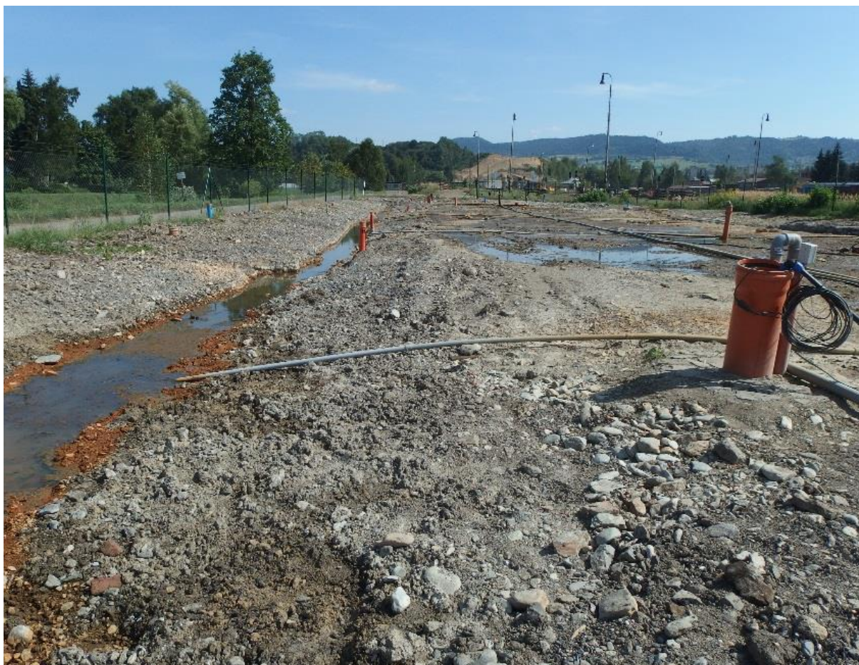
Obr. č. 6 Sanácia zemín in situ bioventingom (Zdroj: MŽP SR)
