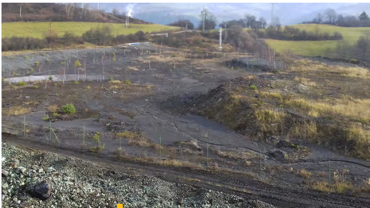
3 Skládka Široká – pohľad zo starej sanovanej skládky na novú skládku s únikom priesakových kvapalín
