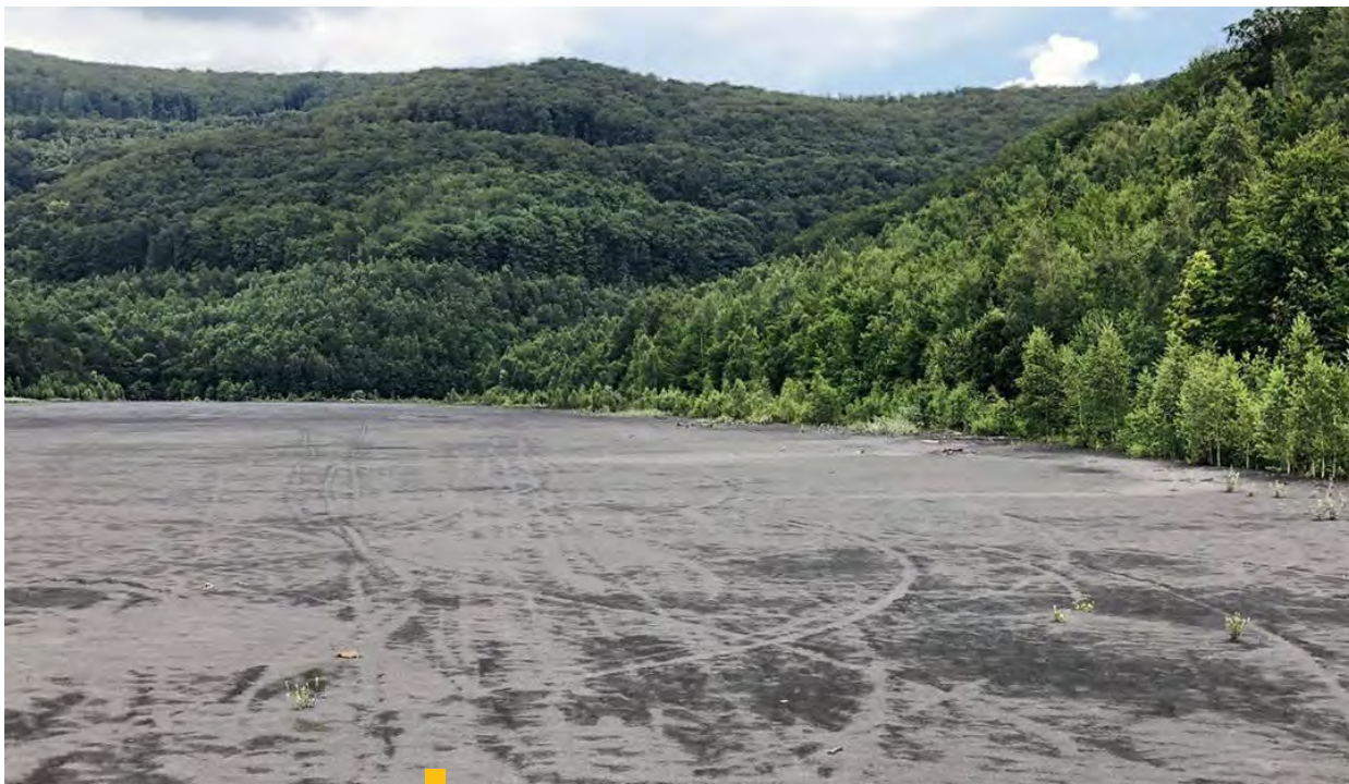
6 Pohľad na pláž odkaliska v Nižnej Slanej v okrese Rožňava, ktoré slúžilo na ukladanie banského odpadu z bane Siderit. Ide o environmentálnu záťaž evidovanú ako RV (010) / Nižná Slaná – banský závod a okolie – SK/EZ/RV/784. Na skládke sa podľa odhadov nachádza 5,5 milióna kubických metrov nebezpečného odpadu, júl 2020 (Zdroj: https://www.facebook.com/photo/?fbid=3104699796251452&set=a.219785170175057 – facebook MŽP SR)
