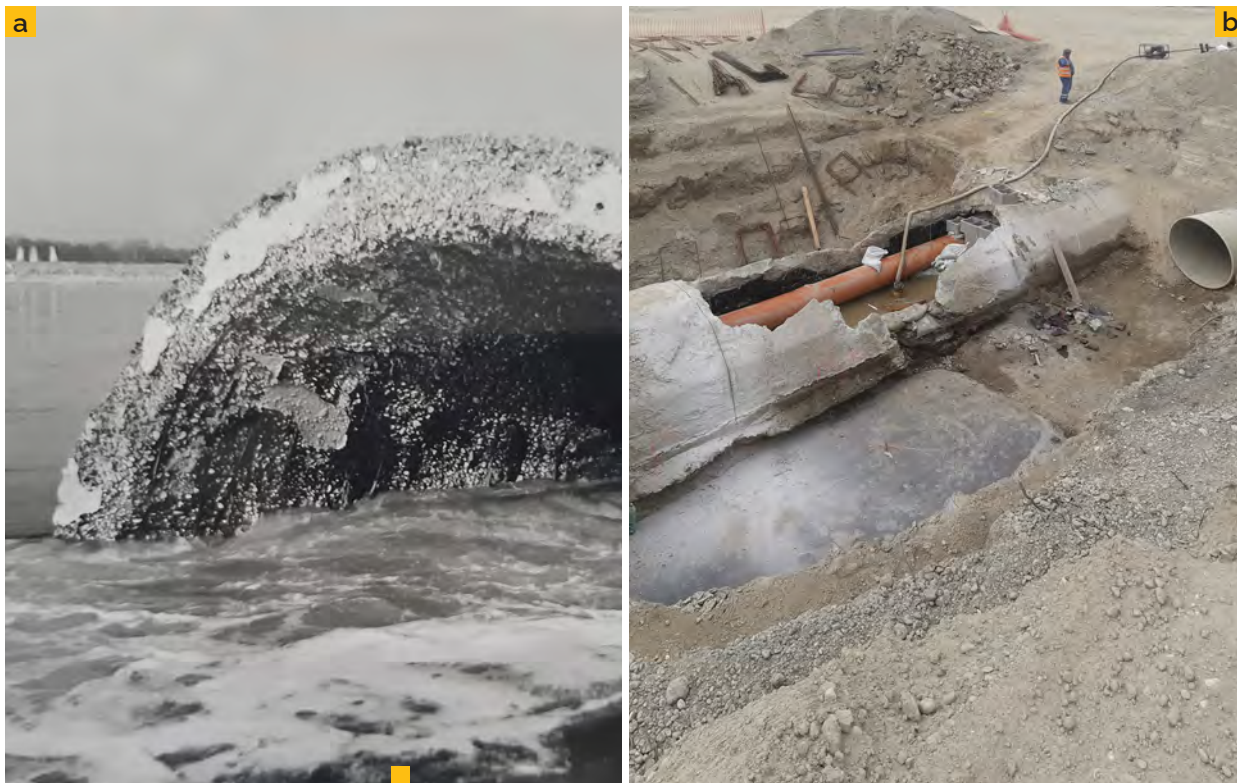
2 a) Pôvodný výustný objekt I. kanála CHOV v roku 1975 b) Odkryté teleso kanála počas prekládky v súvislosti so stavebnými prácami na diaľničnom úseku R7 Prievoz-Ketelec (október 2019)
