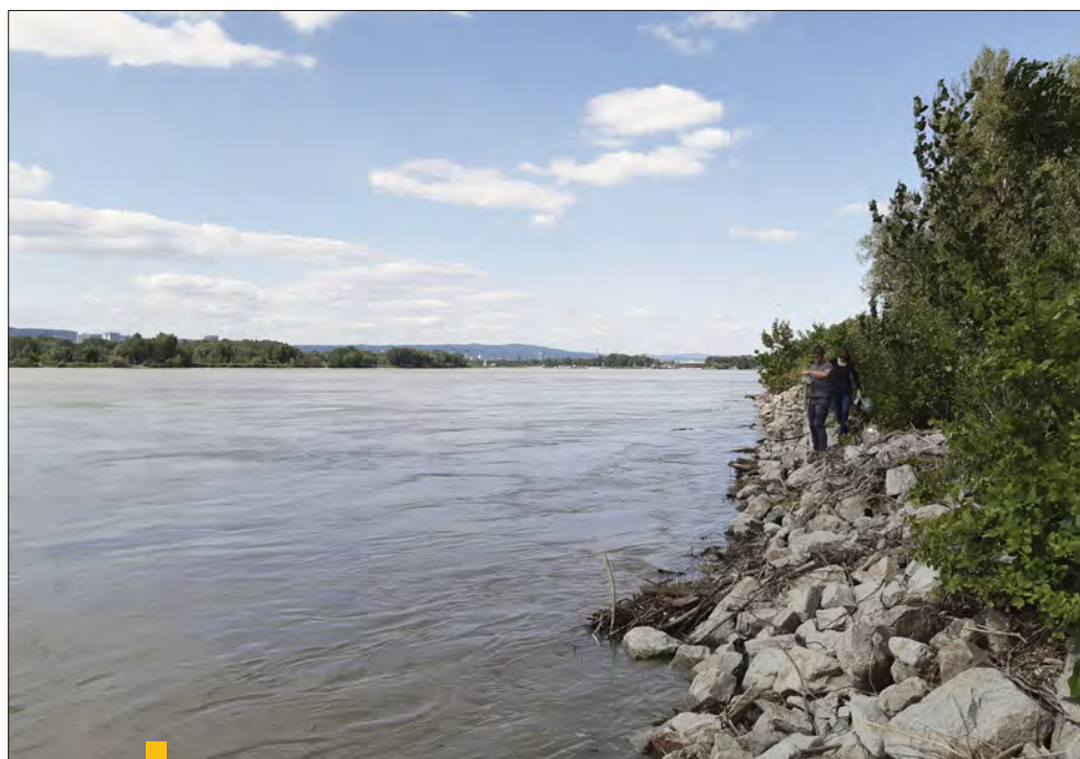
6 Odborné miesta PV-4 a PV-5 na brehu Dunaja, tu sa pod hladinou nachádza ústie I. kanála CHOV
