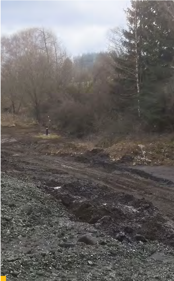
4 Skládka Široká – zeminou provizórne prehradený obvodový rigol
