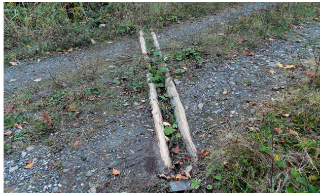
Znefunkčnená (nevyčistená) odrážka z guliačov
