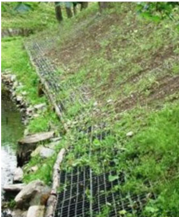
Oživené drôtené konštrukcie
