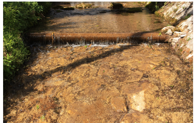
Drevený prah s dláždeným dopadiskom
