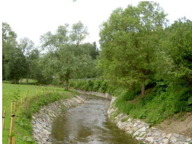
Smerová úprava vodného toku v jeho pôvodnom koryte
