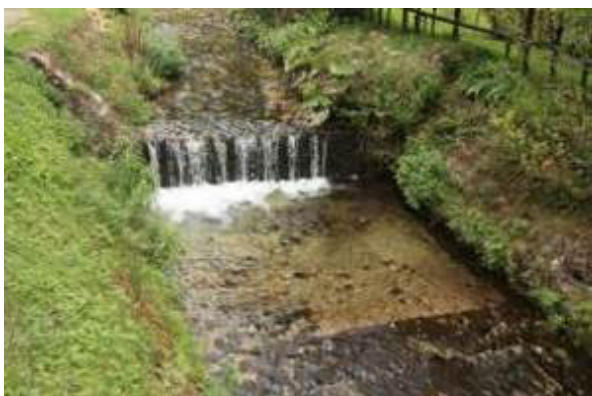
Kombinovaný stupeň z lomového kameňa a drôtovoštrkových blokov
