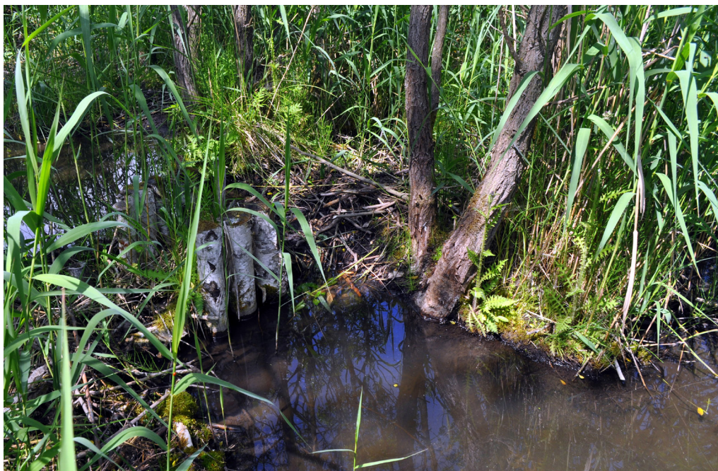
Prehrádzka tvorená dvoma radmi drevených kolov, medzi ktorými je nabitá rašelina, lokalita Krivý Kút (Spišská Belá)
