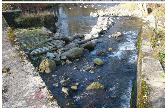
Doplnenie stupňov o rybovody
