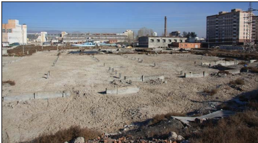
Obr. 1 Čistírenské kaly s vysokým obsahem především těžkých kovů deponované v prostoru ČOV Hargia; viditelně překročena kapacita původních betonových kazet kalového hospodářství; v pozadí relativně blízko od průmyslového areálu obytné domy a sídliště
