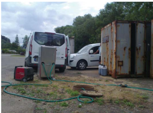
Obr. 3 Aplikace nZVI do vrtu HP-105 31. 7. 2013
