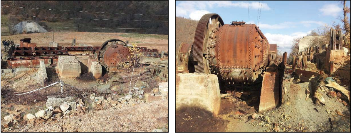
Obr. 2 Bývalá flotační jednotka a koncentrátor s přilehlými haldami hlušiny
